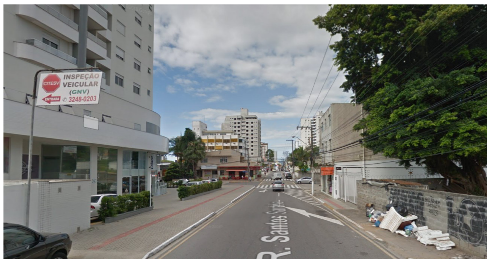
Rua 01 - Trecho B
