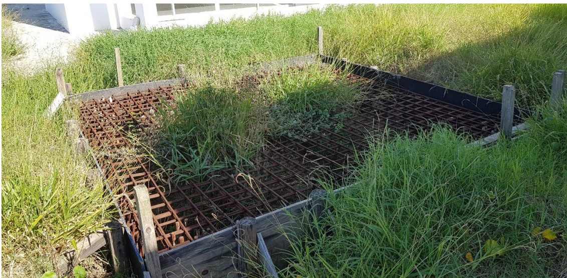
Foto 9 - Fundação para Implantação do Reservatório de Água – Neim Red Park
