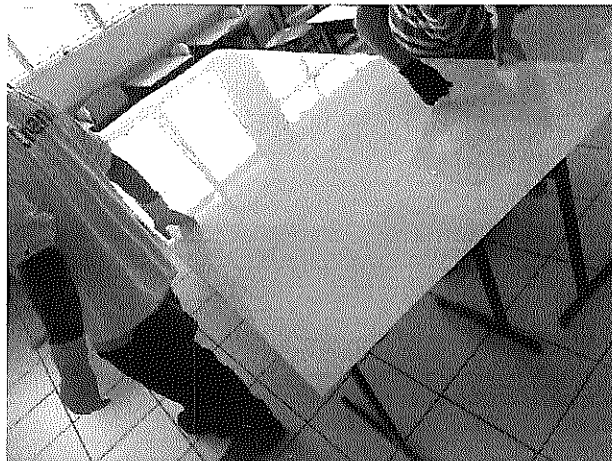
SUBSTITUIÇÃO DE LÂMINAS DE LOUSA FÓRMICA
