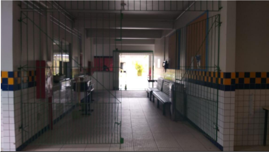
Portão de entrada principal para acesso à escola
