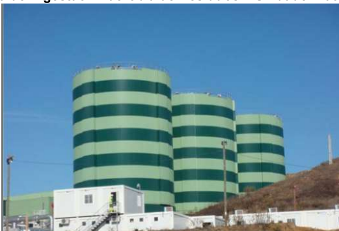
Figura 26: Usina de Digestão Anaeróbia de Resíduos – Unidade Tratolixo – Portugal.
