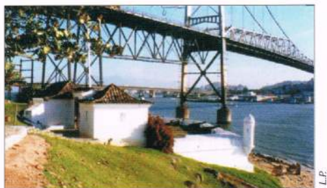
Figura 236 - Vista geral do Forte Santana (1761) e ao fundo a Ponte Hercílio Luz (1926).
