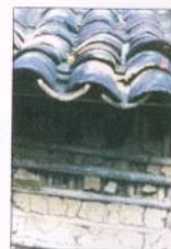
Figura 229, 230 e 231 - Engenho construído em pau-a-pique no Canto da Lagoa, Florianópolis.
