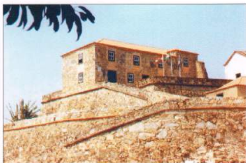
Figura 238 - Vista da Fortaleza São José da Ponta Grossa (1740), Ilha de Santa Catarina e seus terraplenos.
