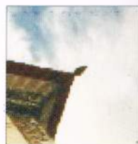
Figura 225 - Os elementos de acabamento da cobertura apresentam rico trabalho.
