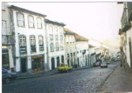
Figura 218 - O casario urbano em Angra do Heroísmo situa-se no alinhamento das ruas, apresentando uma feição homogênea.
