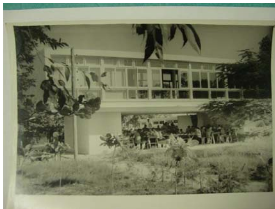
14 – Restaurante com obras concluídas (Acervo Maria Helena Petry Makowiecky)
