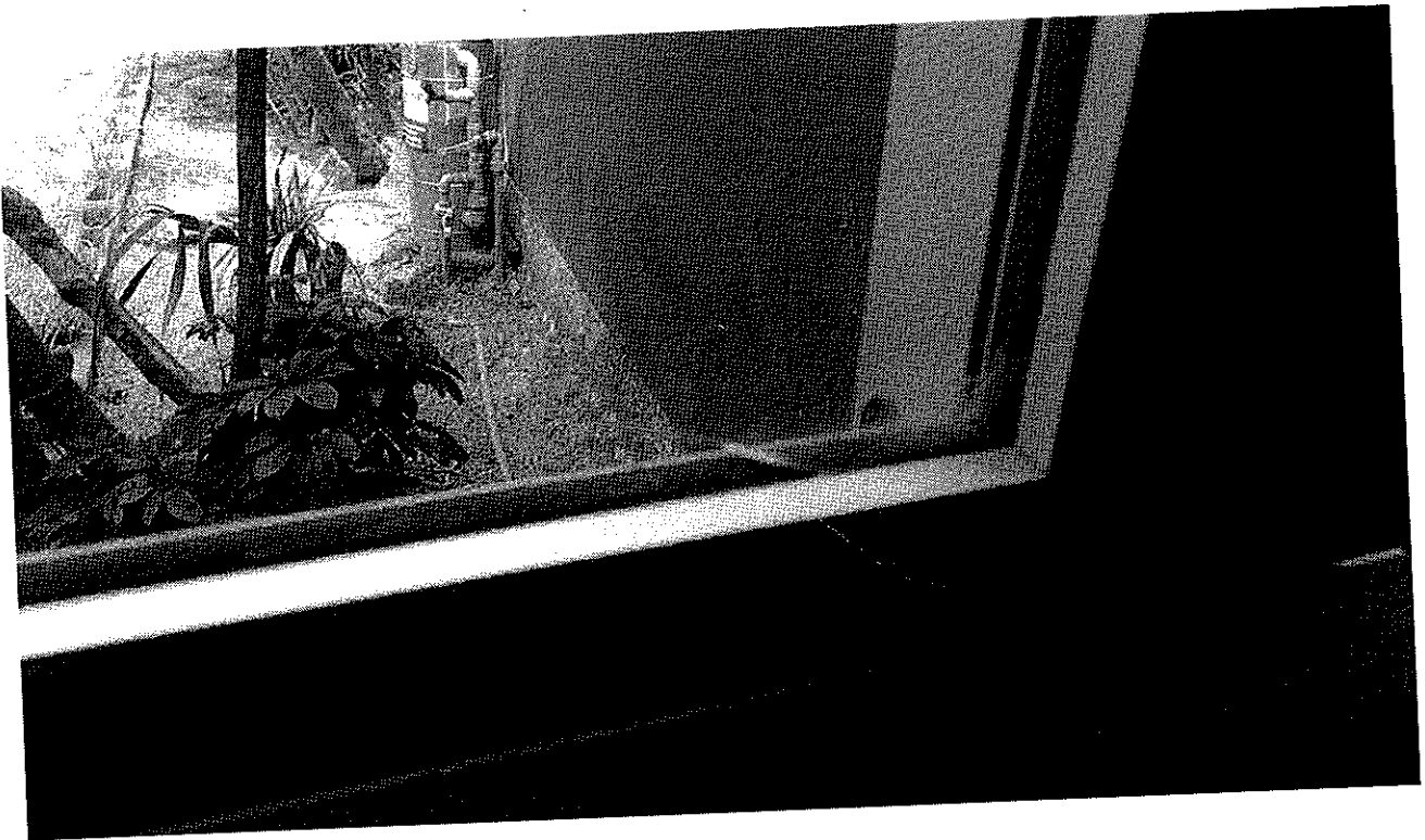
Vidro quebrado/trincado da Sala Informatizada (3)
