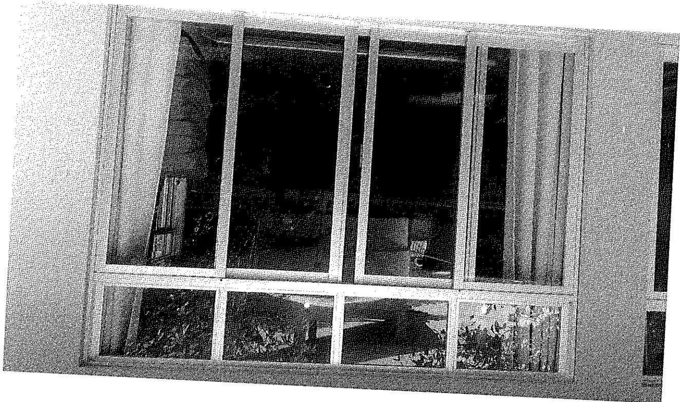
Troca do vidro da janela da Sala da Educação Infantil
