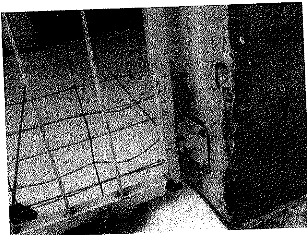
Conserto portão: fixação no muro
