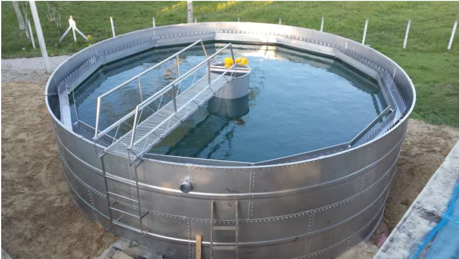
Execução do Decantador Secundário - ETE Saco Grande
