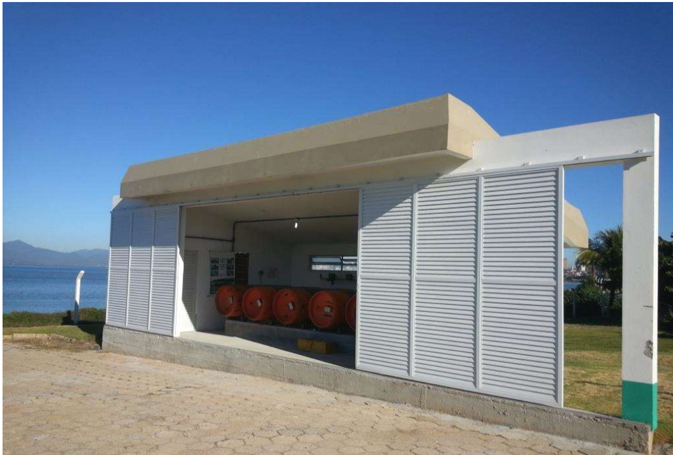
Casa de cloro para desinfecção - ETE Insular
