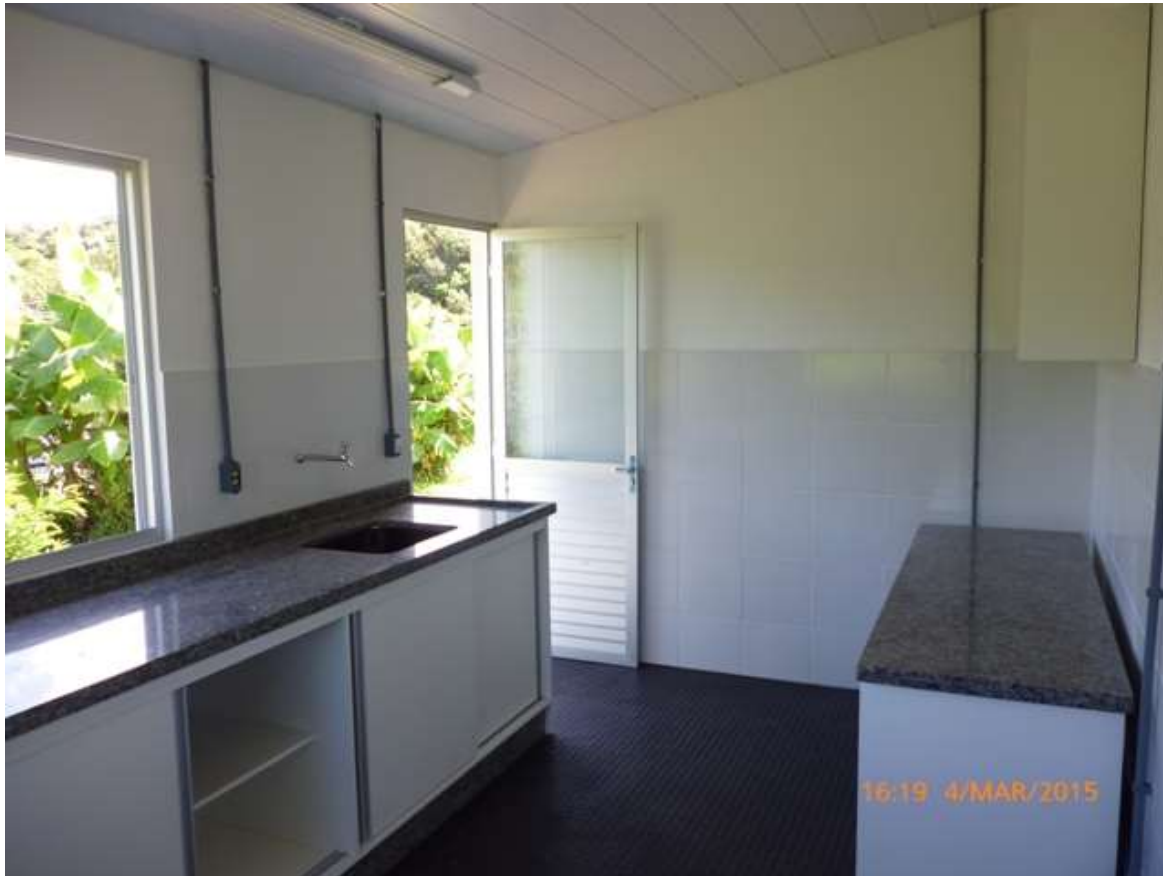
Execução de sala de controle operacional - ETE Lagoa da Conceição
