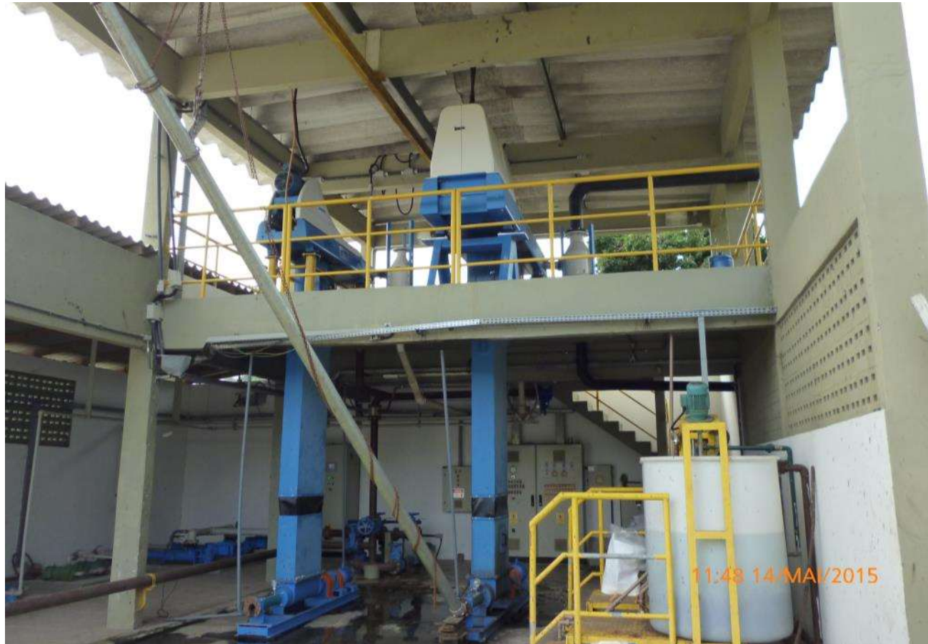
Instalação da segunda centrífuga - ETE Canasvieiras
