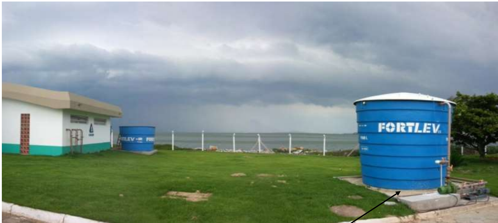
Sistema de dosagem de alcalinizante - ETE Insular
