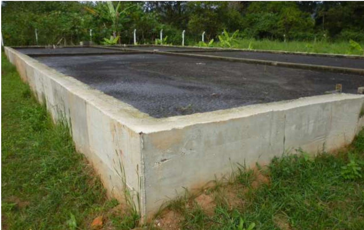
Recuperação estrutural dos leitos de secagem - ETE Canasvieiras
