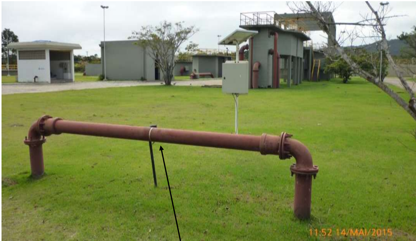
Instalação de macromedidores - ETE Canasvieiras
