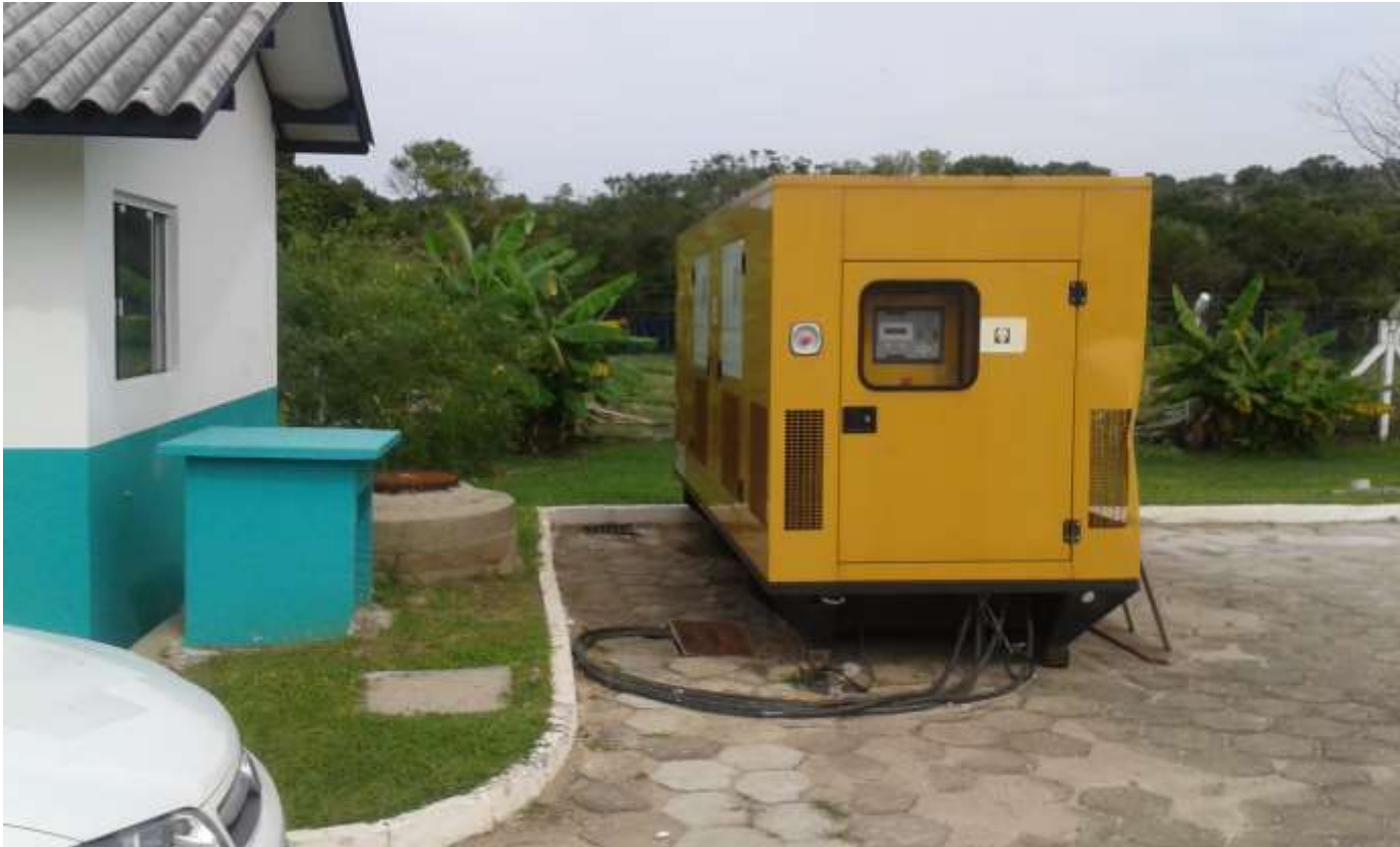
Instalação de geradores - ETE Lagoa da Conceição
