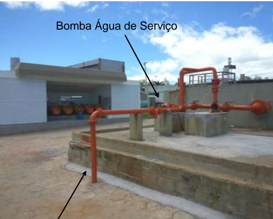
Recuperação do barrilete de água de serviço – uso interno ETE Insular
