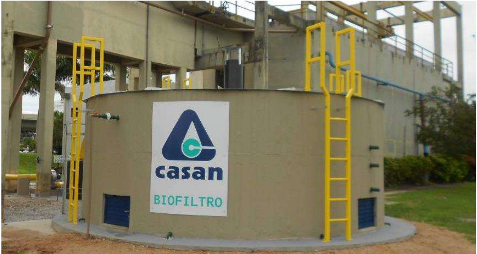
Instalação de biofiltro - ETE Insular
