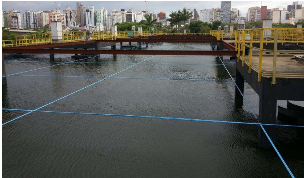
Reforço estrutural do Tanque de Aeração 02 - ETE Insular
